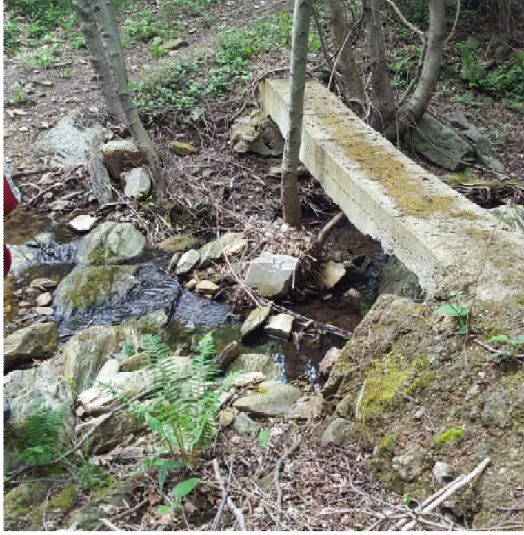
Resim 9 Zile-2 Kaynağı – Mevcut Depo Arası İsale Hattı Dere Geçişi
